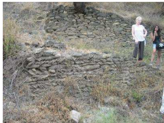
Vista del muro
